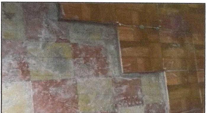
Foto 4: SUSTITUCIÓN POR PISO CERÁMICO
