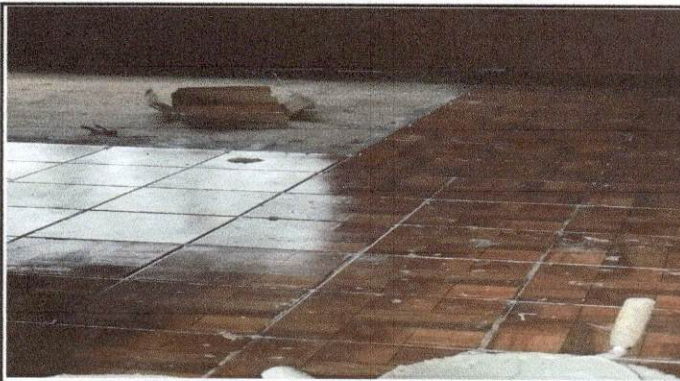
Foto 3: SUSTITUCIÓN POR PISO CERÁMICO
