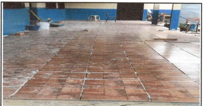
Foto 6: SUSTITUCIÓN POR PISO CERÁMICO
